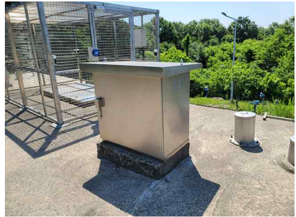
손상내용 외부 현장제어반 상태양호 손상원인 -
