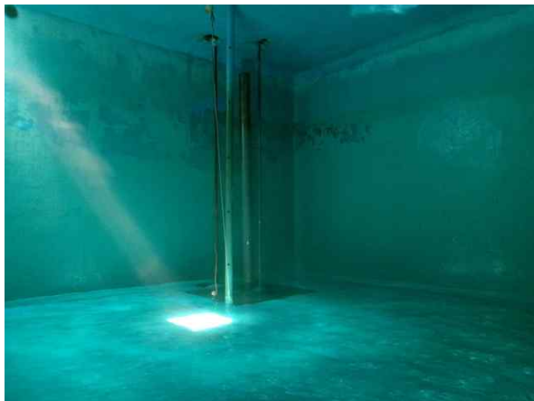
배수지 1지 내부 전경
