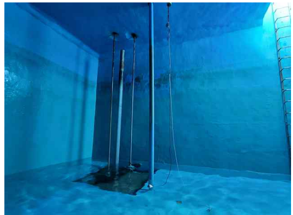
배수지 2지 내부 전경
