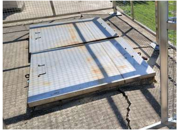
환기구 등의 덮개(장비 반입구) 현황
