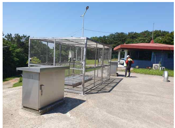
배수지 상부 현황
